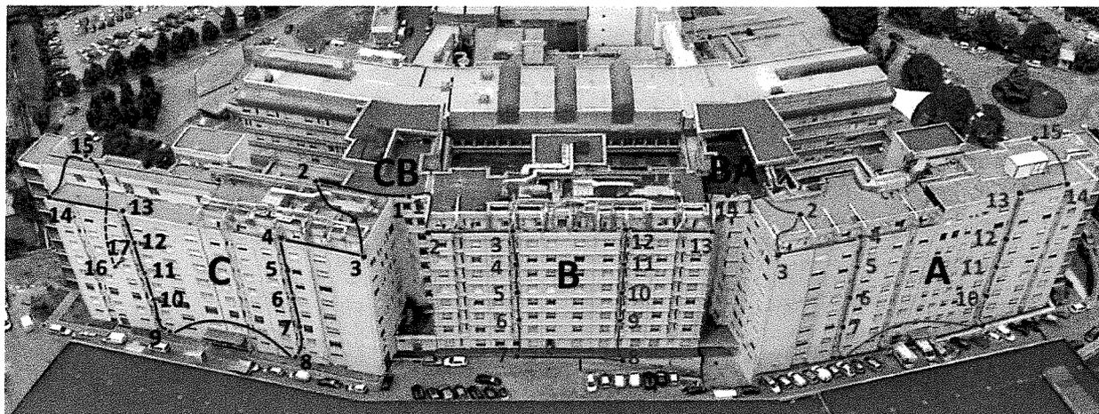
Fig.6 Disposizione punti di misura su immagine prospettica (vista da monte) del monitoraggio dinamico effettuato
